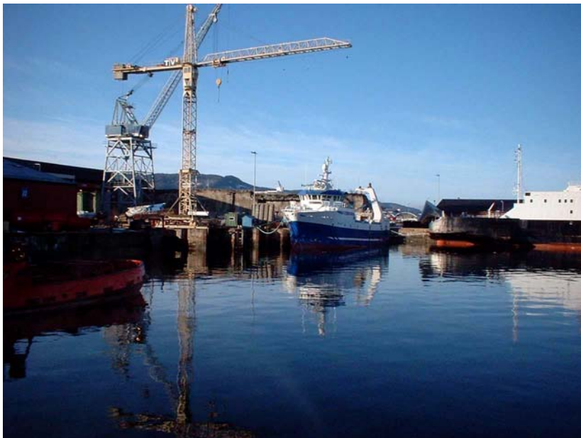
Bilde 11: Den nye seitråleren etter forlengelsen 6 meter midtskips
